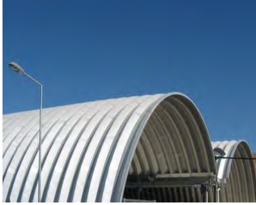
Şekil 10: Kısa Vadede Üst Örtü Sorunu İçin Önerilen Çelik Tonoz Çatılar
