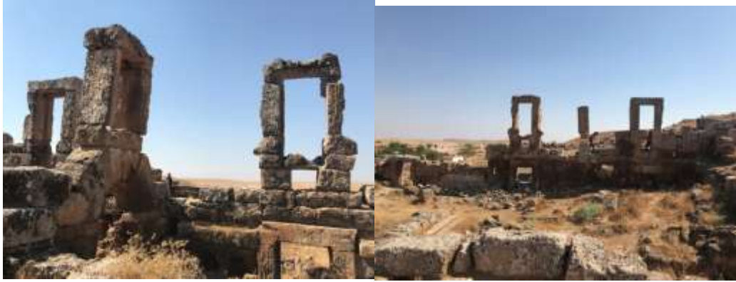
Şekil 10: Kentte Ayakta Kalan Yapı Elemanları
