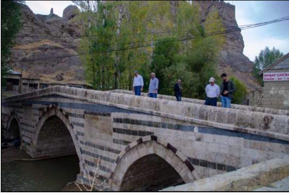
Foto 11: Evliya Bey Köprüsü
