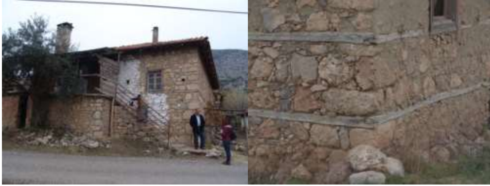
Fotoğraf 1. Antalya ve Serik taş meskenleri toprak/kerpiç meskenlere nazaran zamana karşı direnmiş örnekler gösterir.
